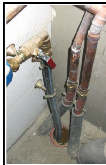
Calfeutrage des entrées de réseaux
