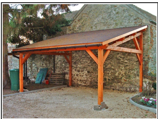
Construction annexe adossée à façade
