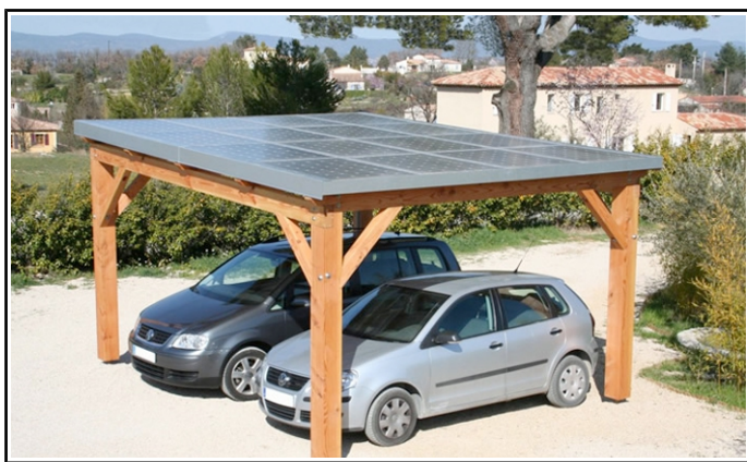
Construction annexe non contiguë
