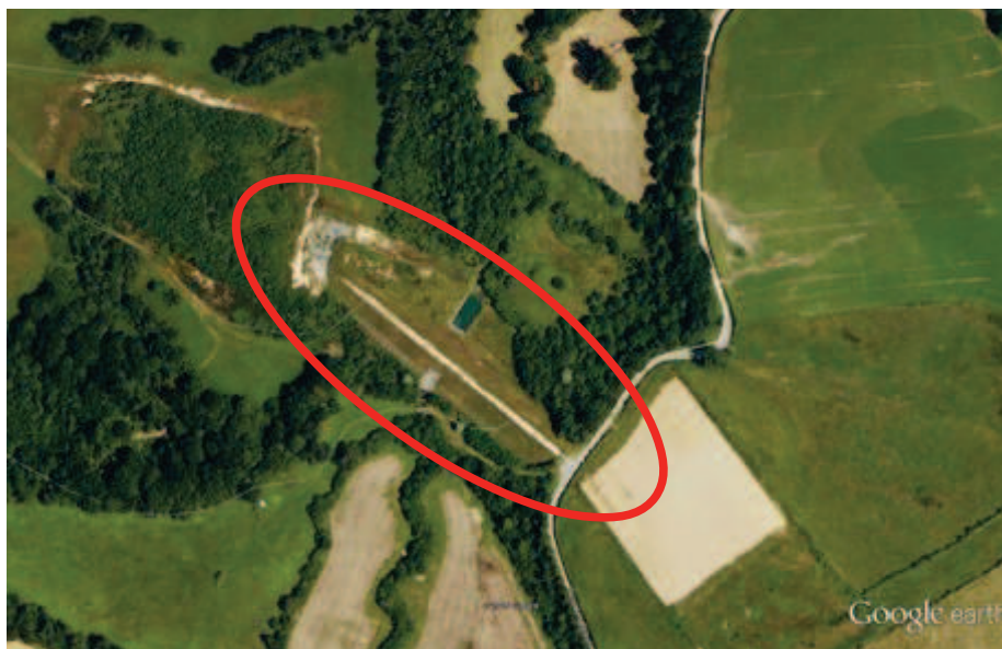
FIG. 5 : Photo du barrage écrêteur de crues des « Mielles » (source : Google Earth)
