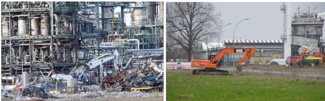
Démantèlement du site
