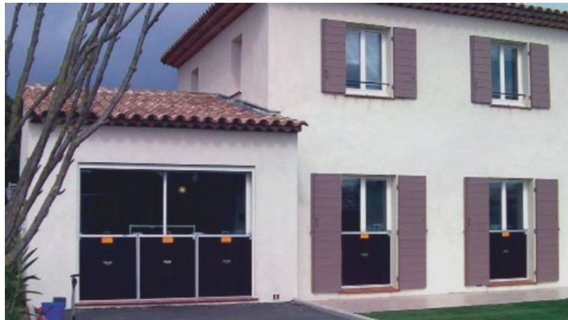
Exemple de protections des ouvertures
