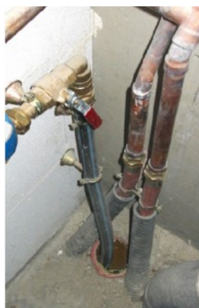
Exemple d'entrées de réseaux à calfeutrer
