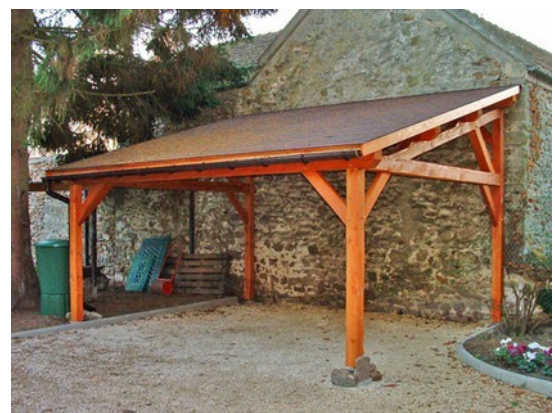
Abri de protection accolé à bâtiment (adjonction)
