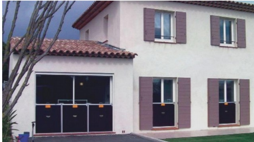
Exemple de protections des ouvertures
