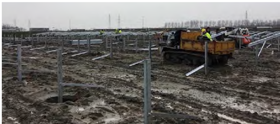
Figure 13 : Mise en place des structures (Source : TotalEnergies)
