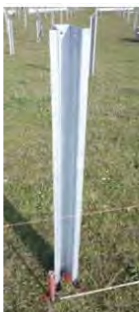
Pieu pour les fondations réduisant les impacts sur l'imperméabilisation des sols © Ministère de l'écologie
