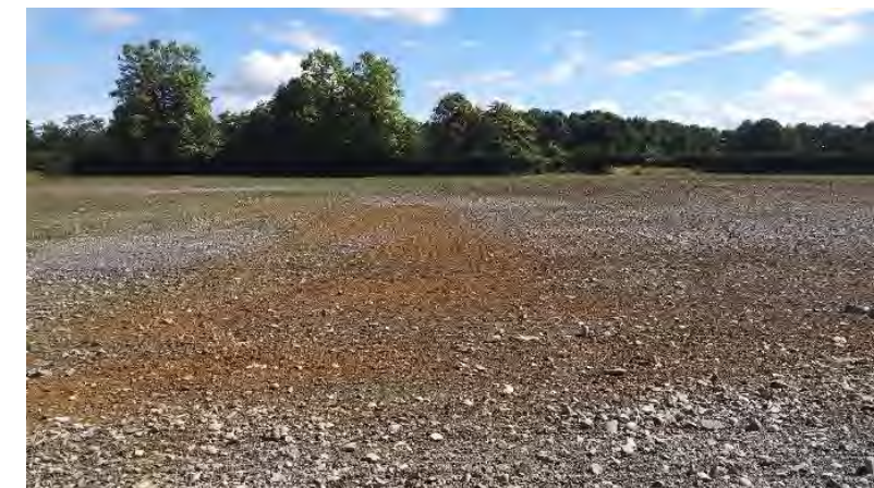
Vue de la plateforme MZS6
